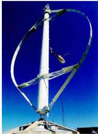
Figura 5: Aerogenerador Darrieus
