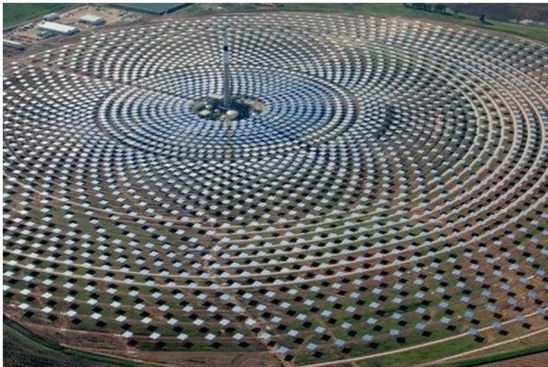
**Ilustración 9. Campo de heliostatos y torre de la central Gemasolar en Sevilla**
