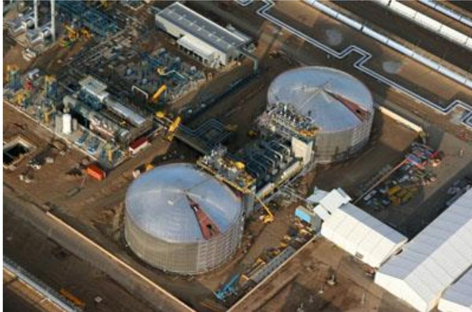
**Ilustración 10. Almacenamiento Andasol, compuesto de dos tanques, uno para sales frías y otro para sales calientes.**
