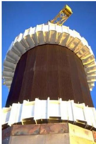
**Ilustración 8. Receptor de Solar Two**
