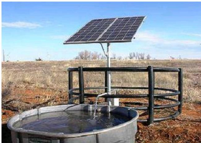
Fig.4.3. Sistema de bombeo mediante paneles fotovoltaicos
