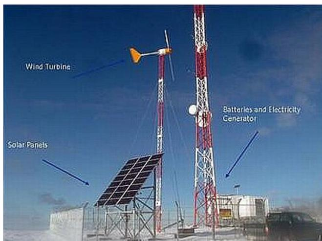
Fig.4.2. Antena de telefonía alimentada por paneles fotovoltaicos
