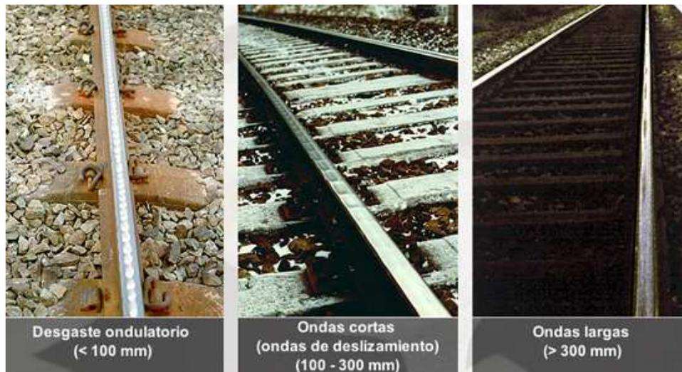
Figura 2.13. Desgaste ondulatorio del carril [200].
