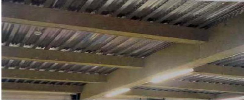
Aislamiento al fuego de perfiles con paneles de yesos laminados especiales o fibrosilicatos
