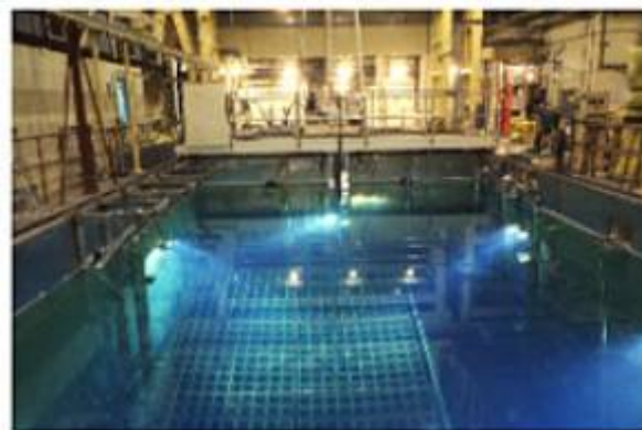
Figura 7. Piscinas de almacenamiento.
