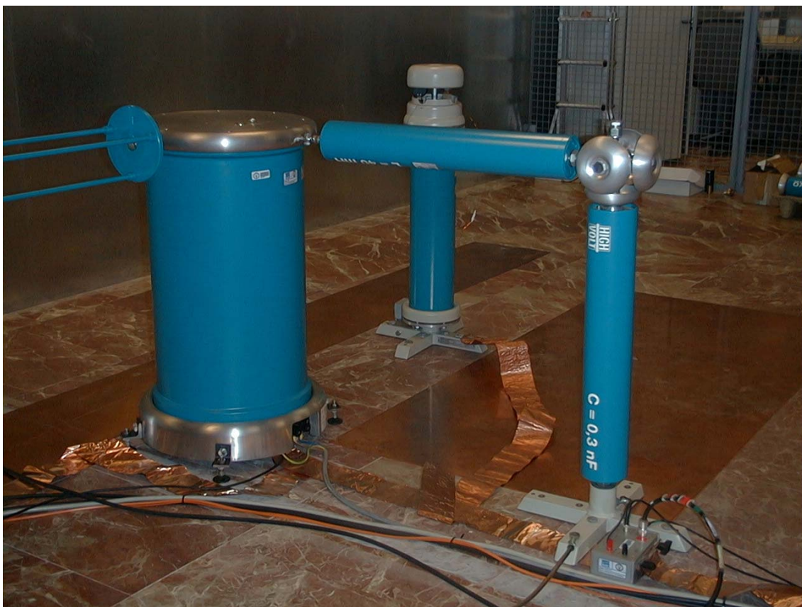
Fig.5.2. Fotografía del montaje
