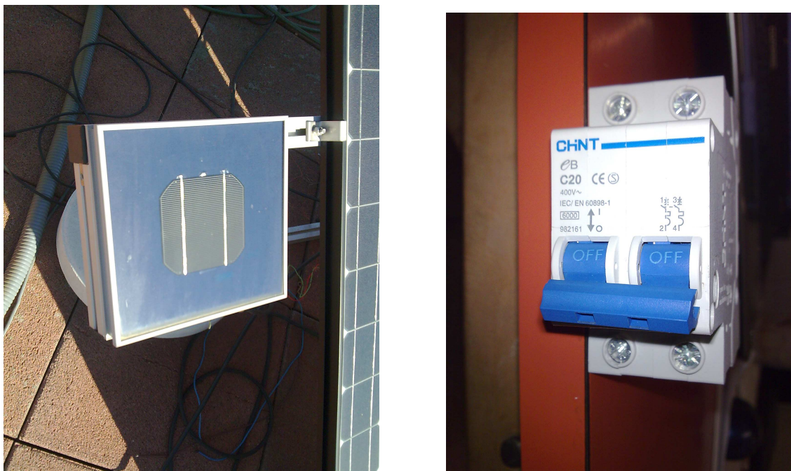
Figura 38. Fotografías de la célula que mide la irradiancia y del tipo de interruptor automático empleado en el módulo medidor de 400V.
