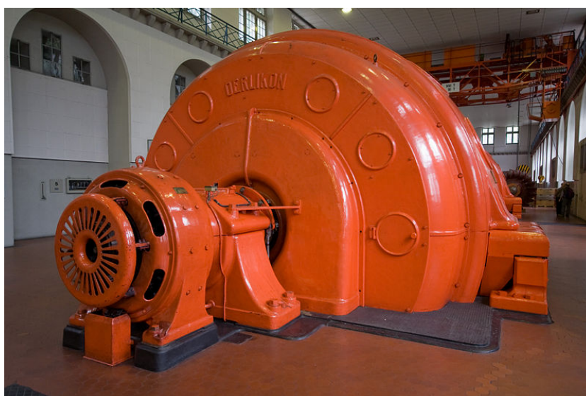
Figura 3.8: Antiguo generador (hoy en desuso) de la central hidroeléctrica de Amsteg, en Suiza, construida hacia 1923. En primer término, la excitatriz.
