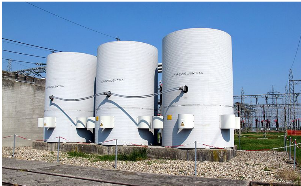
Figura 3.15: Bobinas para el consumo de 100 Mvar de potencia reactiva en la subestación de Dürnrohr, Austria. Las reactancias se encuentran conectadas en estrella; en primer término y a media altura, el cable de conexión de neutro.
