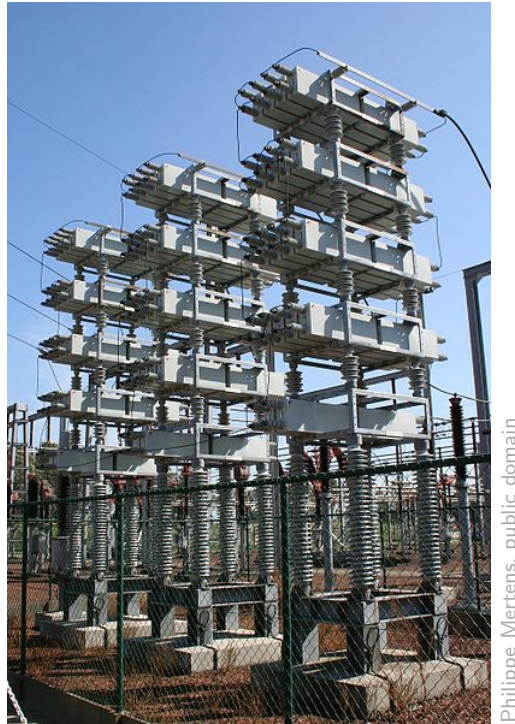
Figura 3.14: Batería de condensadores de 75 Mvar, 150 kV, en la subestación de Zandvliet, Bélgica.
