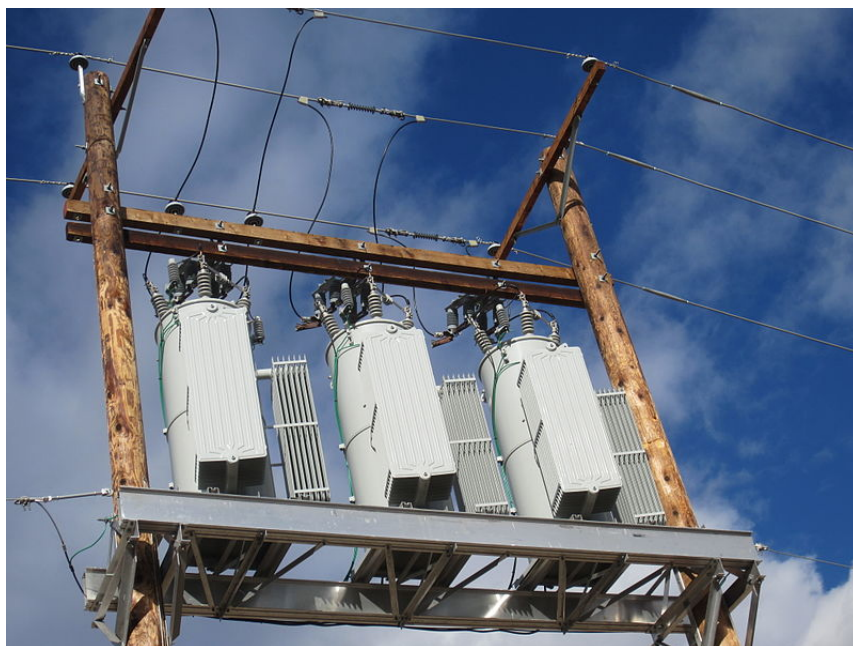
Figura 3.22: Reguladores de tensión tipo SVR montados sobre postes de madera. Cada regulador tiene tres pasatapas. Por el tamaño de los pasatapas y por la distancia de aislamiento entre conductores puede comprobarse que la tensión nominal en el primario y el secundario es la misma.
