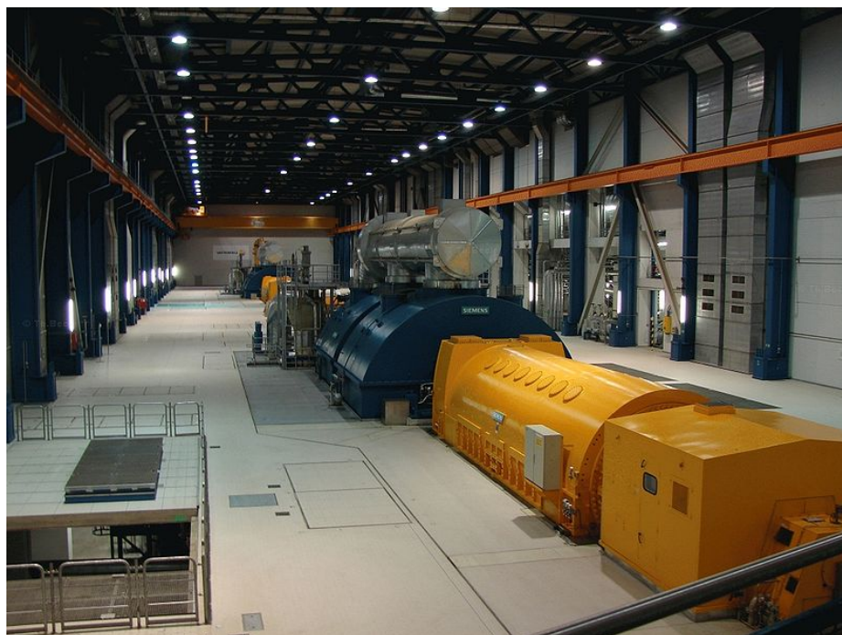
Figura 3.7: Sala de turbinas de la central térmica de Schwarze Pumpe, en Alemania, en servicio desde 1998. En primer término, dentro de una cubierta cuadrangular amarilla, el sistema de excitación; detrás, en un cilindro amarillo, el generador síncrono de 800 MW; detrás, en un cilindro azul, la turbina.
