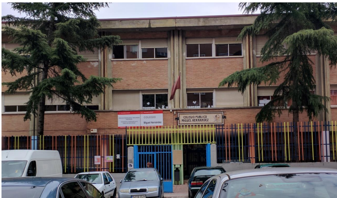
Ilustración 58. Fachada del CEIP Miguel Hernández de Fuenlabrada. Fuente: elaboración propia
