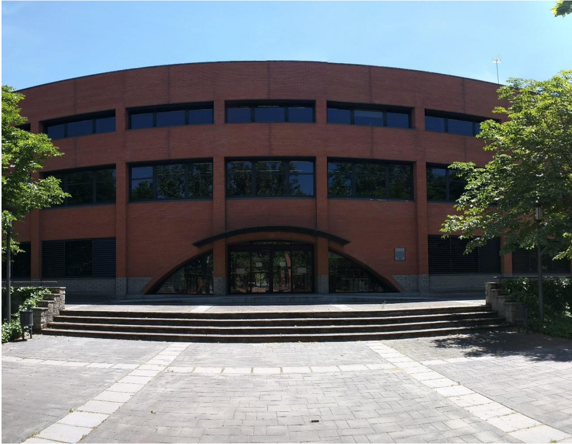
Ilustración 74. Fotografía del edificio 14 del campus de Getafe de la UC3M. Fuente: elaboración propia
