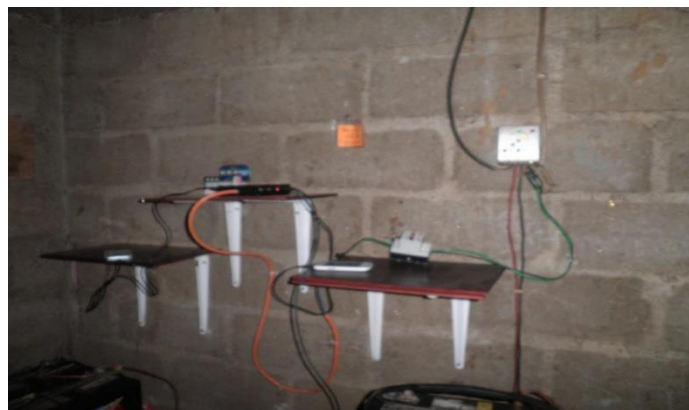
Figura 52: Conexión correcta del multicargador al regulador
