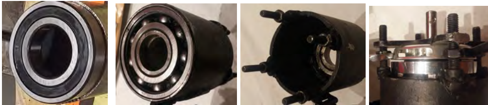
Figura 8.54 Montaje del motor eléctrico en la carcasa cilíndrica de protección
