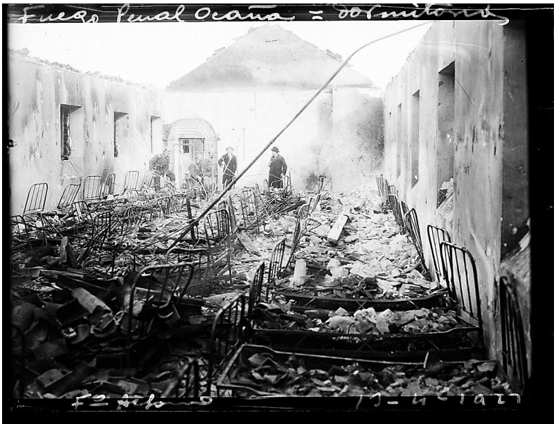
Imagen del deterioro producido por el incendio.
