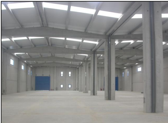
Figura 1.1: Nave de hormigón.
