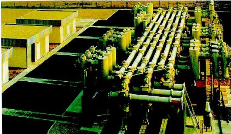
Figura 3: Subestación encapsulada o aislada en SF<sub>6</sub>
