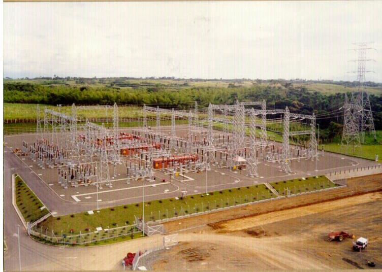
Figura 2: Subestación convencional aislada al aire
