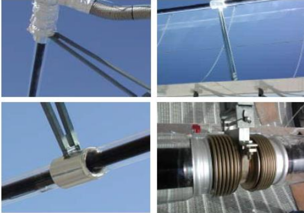
Figura 36. Ejemplos de uniones del brazo soporte y tubo receptor [19]
