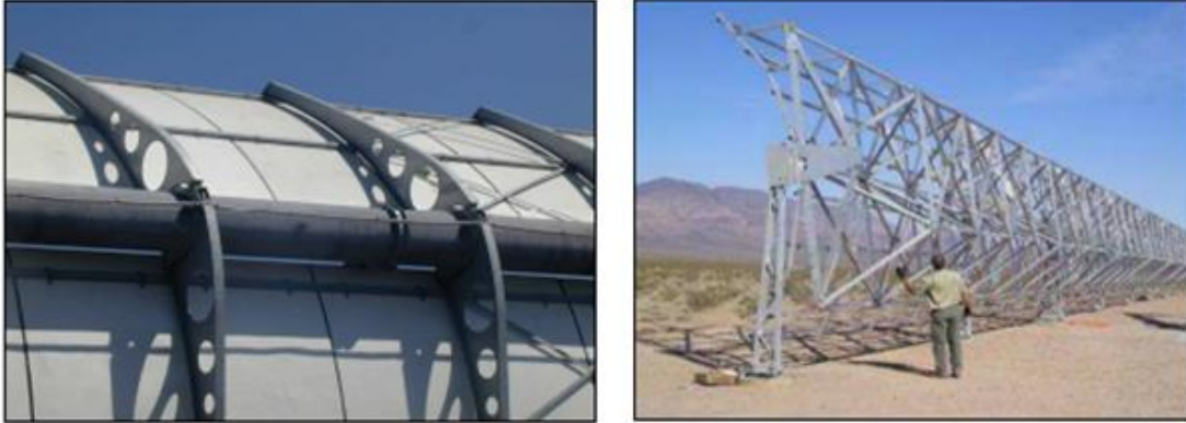
Figura 15. A la izquierda, estructura torque tube y a la derecha, estructura torque box
