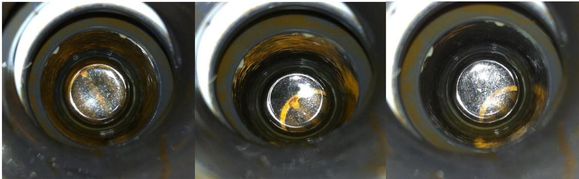
**Figura 52.** Diferentes posiciones de la válvula de compuerta donde se aprecia el estrechamiento del área de paso.
