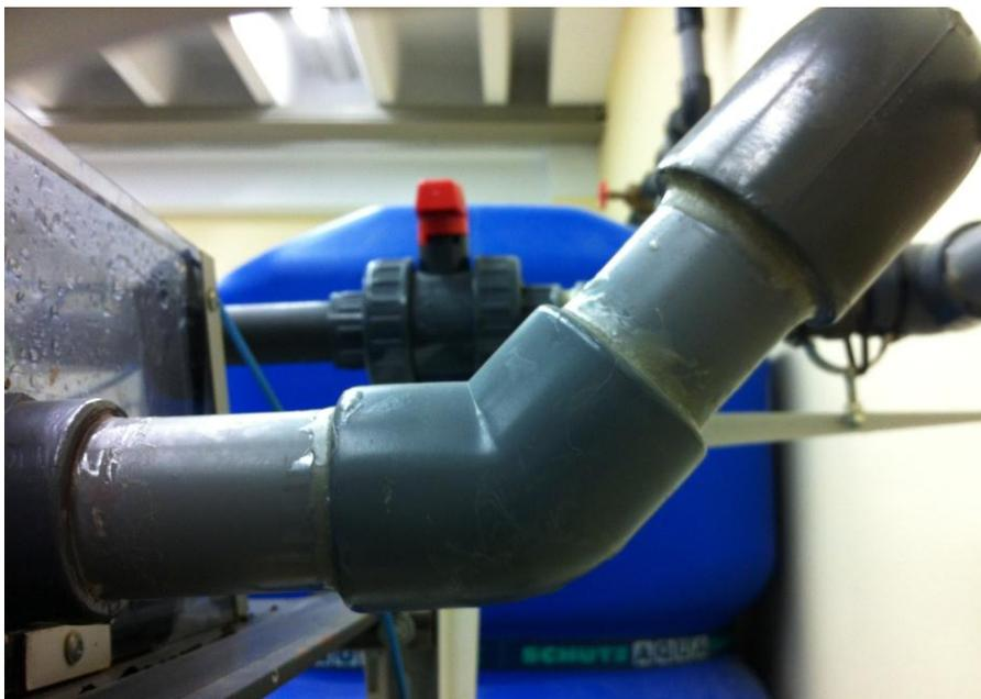
**Figura 58.** Fotografía de la conexión para el montaje de la turbina Pelton
