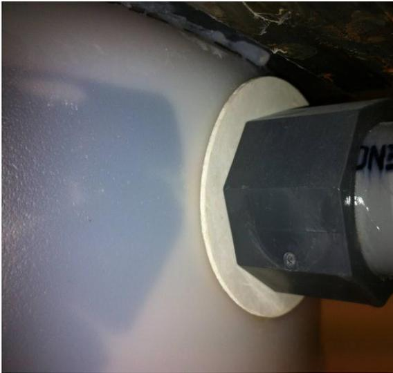
**Figura 35.** Entrada lateral al depósito
