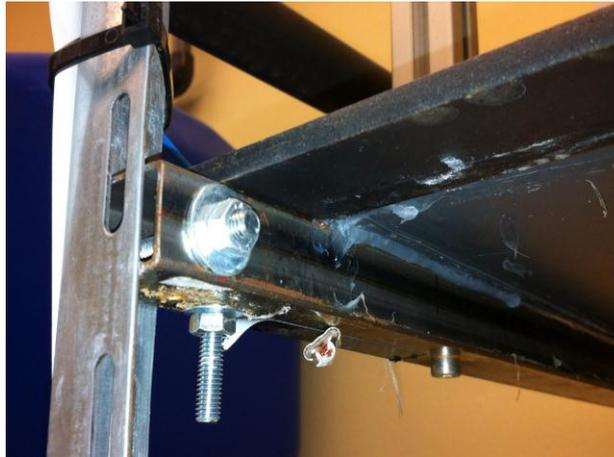
**Figura 38.** Detalle de estructura de soporte de cúpula
