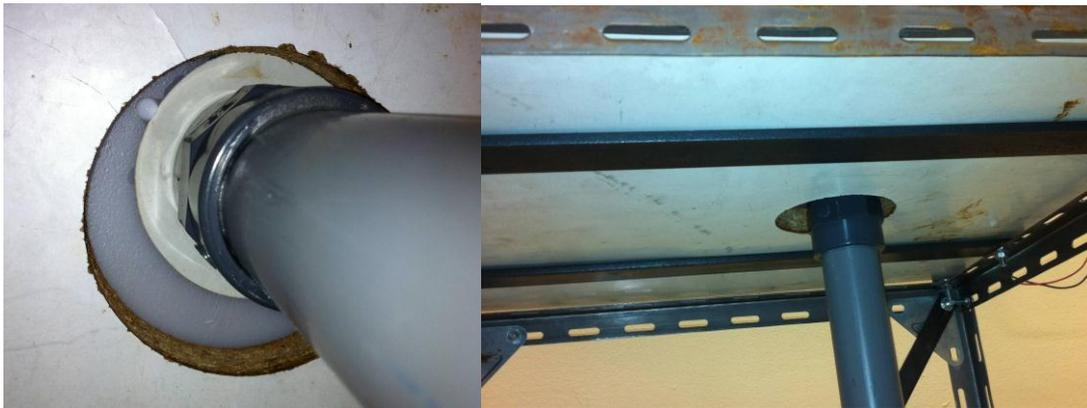
**Figura 36.** Entrada inferior al depósito
