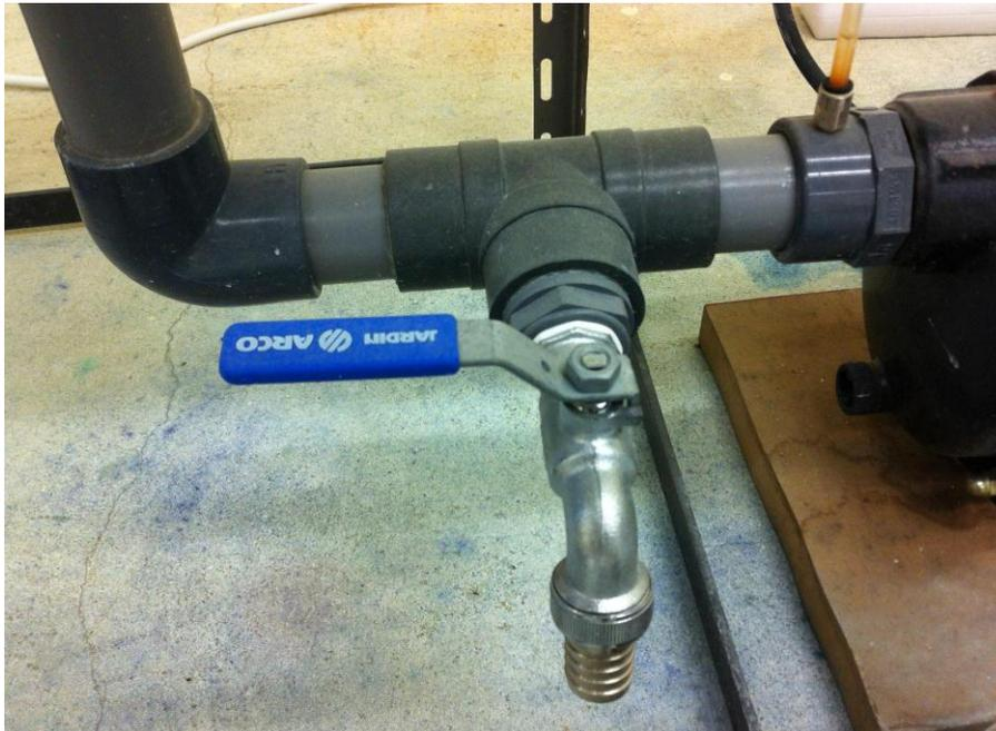
**Figura 55.** Sistema de purga del depósito y toma de presión en la boca de aspiración de la bomba
