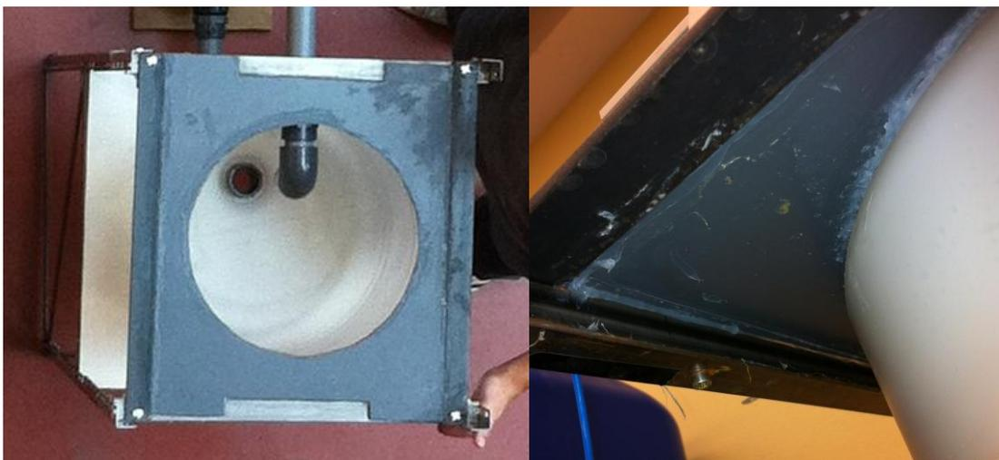
**Figura 39.** Lamina de apoyo de la cúpula vista desde arriba (izquierda) y desde abajo (derecha) donde se aprecia la unión al depósito y a la estructura mediante silicona
