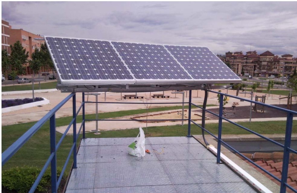
Figura 4.14 Instalación de los paneles solares
