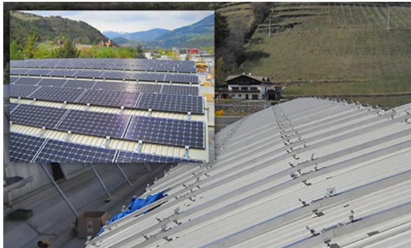
*Figura 0.2. ESTRUCTURA SolidRail EN CHAPA TRAPEZOIDAL.[Fuente: Elaboración propia]*
