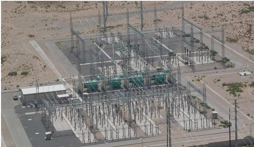
**Figura 3.** Subestación de intemperie.
