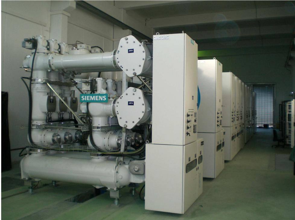
**Figura 4.** Subestación GIS e interior.
