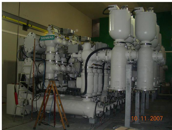
**Figura 6.** Subestación GIS La Cereal 220kV, vista lateral.
