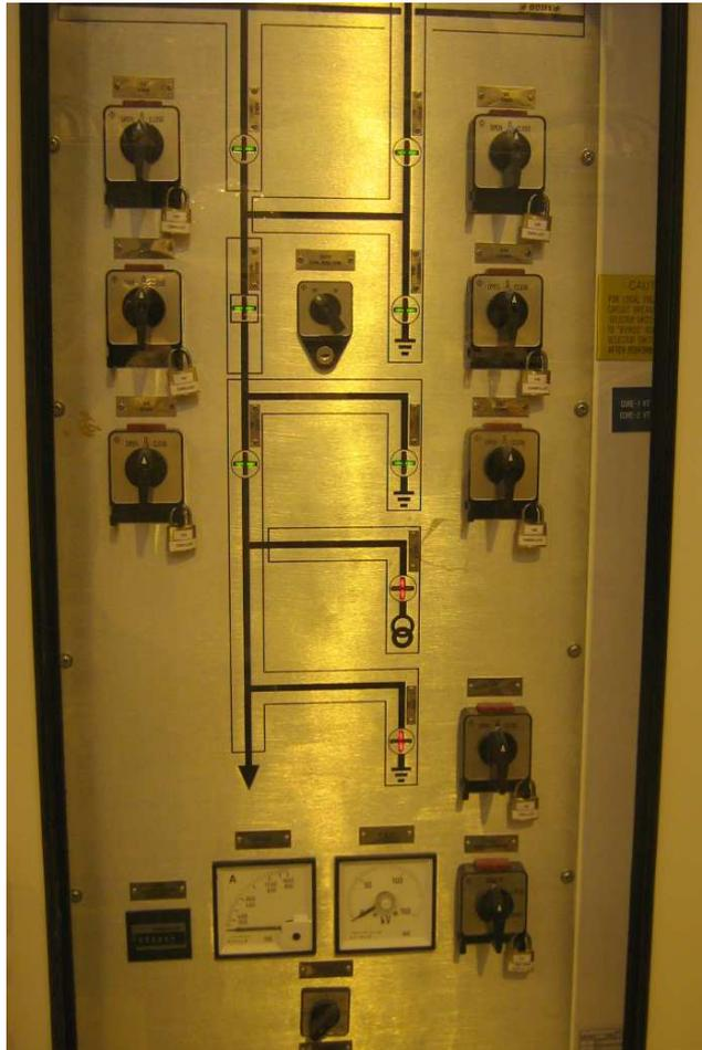
**Figura 29.** Armario de control local de posición de línea de una subestación GIS.
