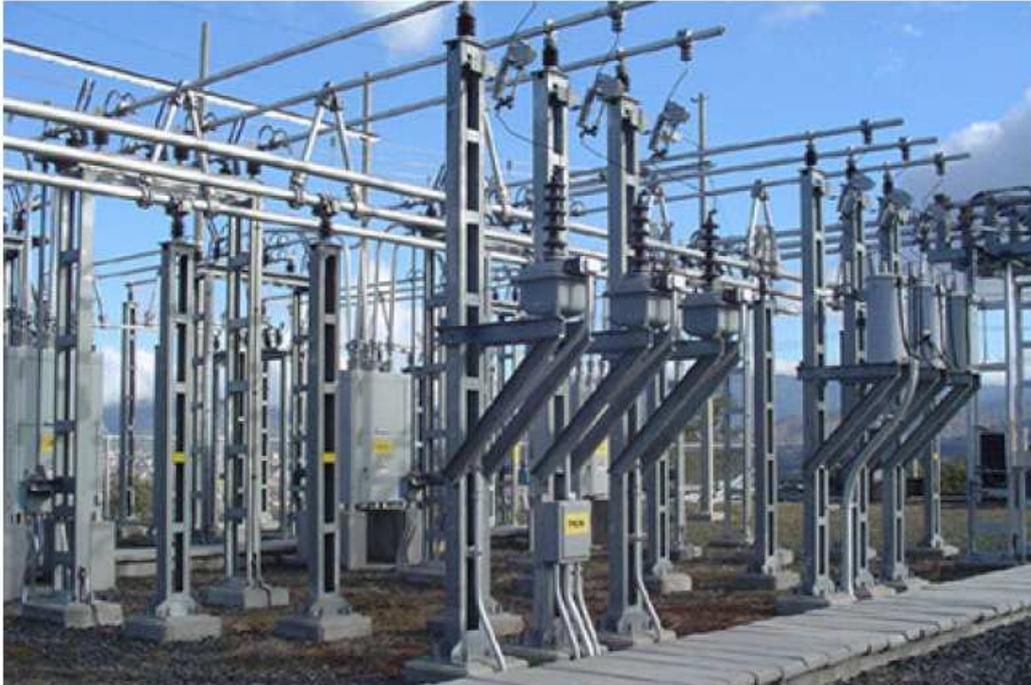
**Figura 5.** Ejemplo de embarrado de una subestación eléctrica.
