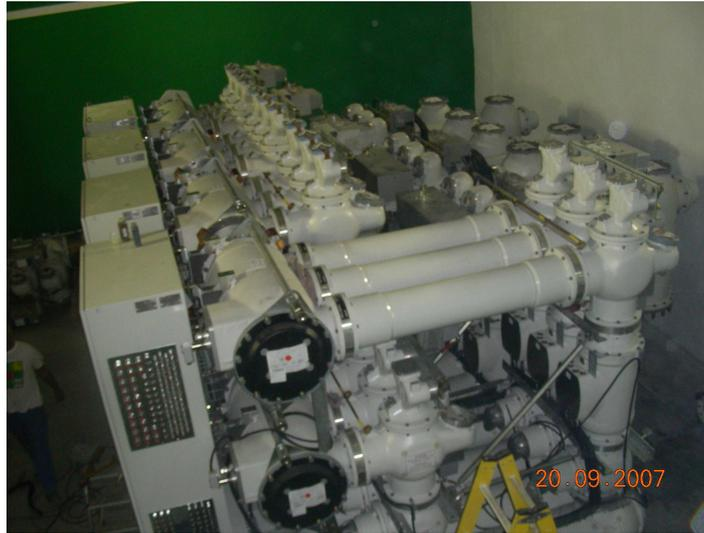
**Figura 7.** Subestación GIS La Cereal 220kV, vista de la parte superior.
