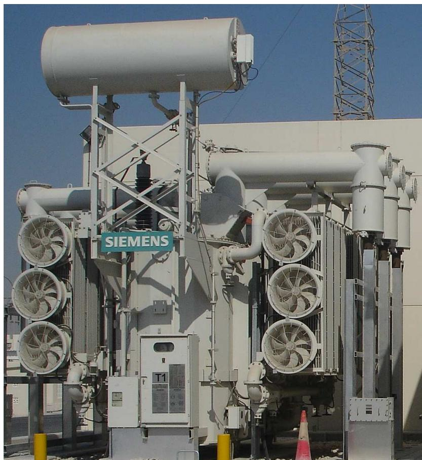
**Figura 30.** Transformador de potencia.
