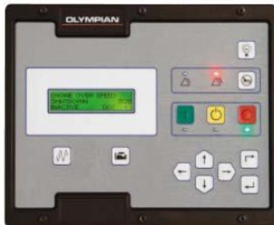
**Figura 7. Panel de control del Grupo Electrónico**
