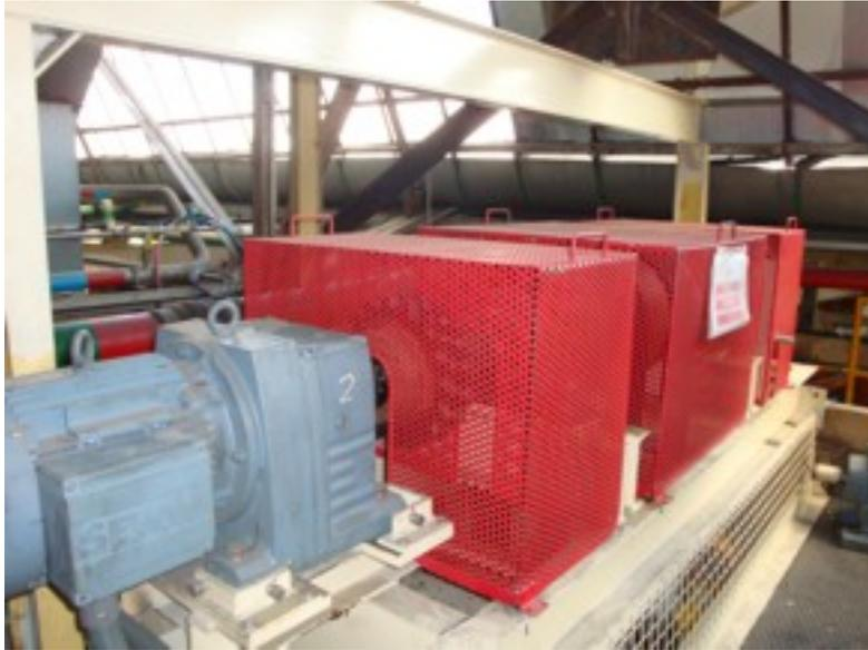
*Figura 4.16. Motor reductor redundante*
