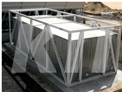
Figura 18: Depósito de acero con tratamiento vitrificado
