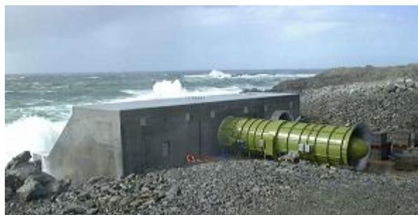
Figura 32: Columna de agua oscilante (OWC) Proyecto LIMPET Escocia. Fuente: Wavegen (www.wavegen.co.uk)
