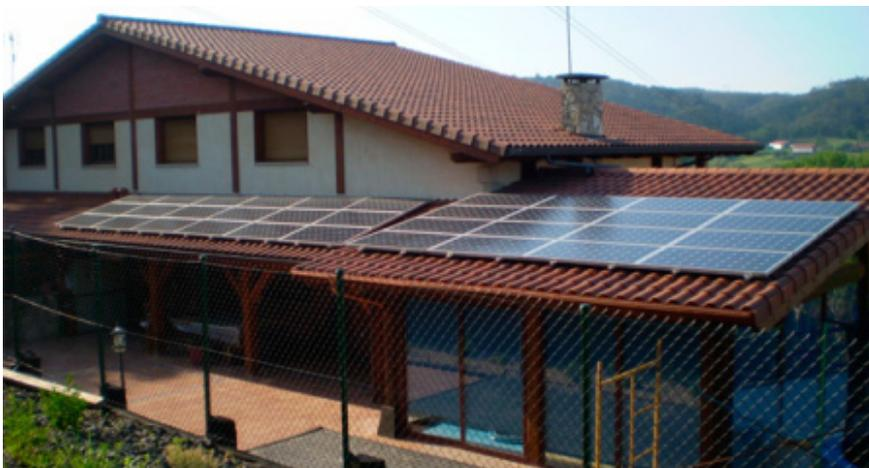
Figura 18: Aplicación de instalación doméstica sobre tejado
